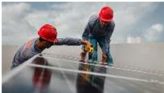
Figura 8: fixação de painéis fotovoltaicos.
