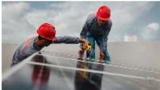
Figura 8: fixação de painéis fotovoltaicos.
