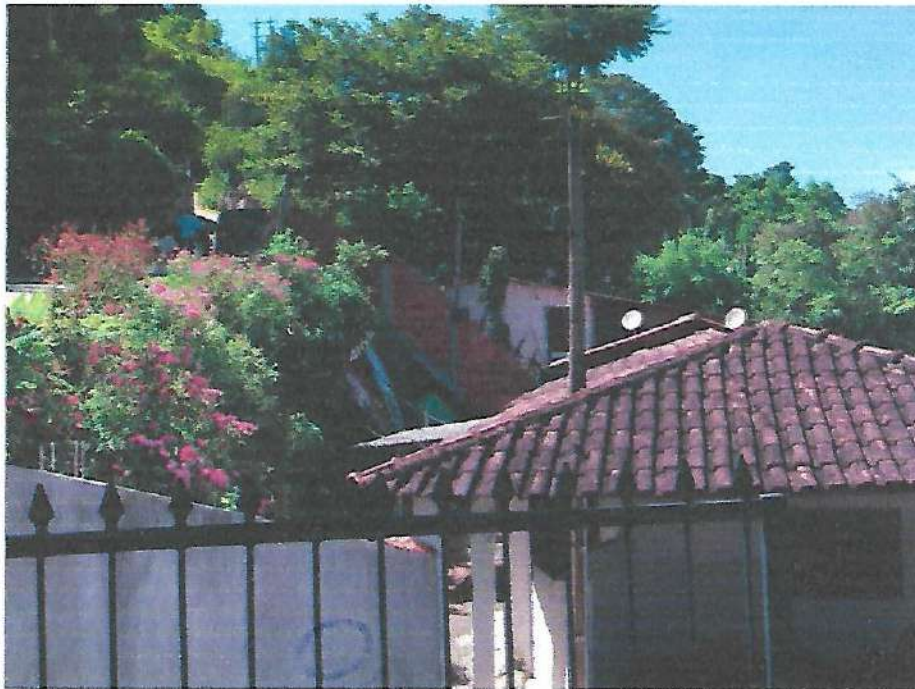
Imóvel localizado na Rua São João, S/N, Bairro do Rocio Grau de risco: leve, com recomendação de monitoramento.
