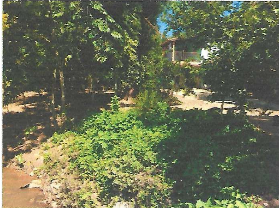
Imóvel localizado na Rua São Pedro, S/N, Bairro do Rocio Grau de Risco: leve, com recomendação de monitoramento. Observação: Somente em dias com grande quantidade de chuva que está sujeito a alagamento.
