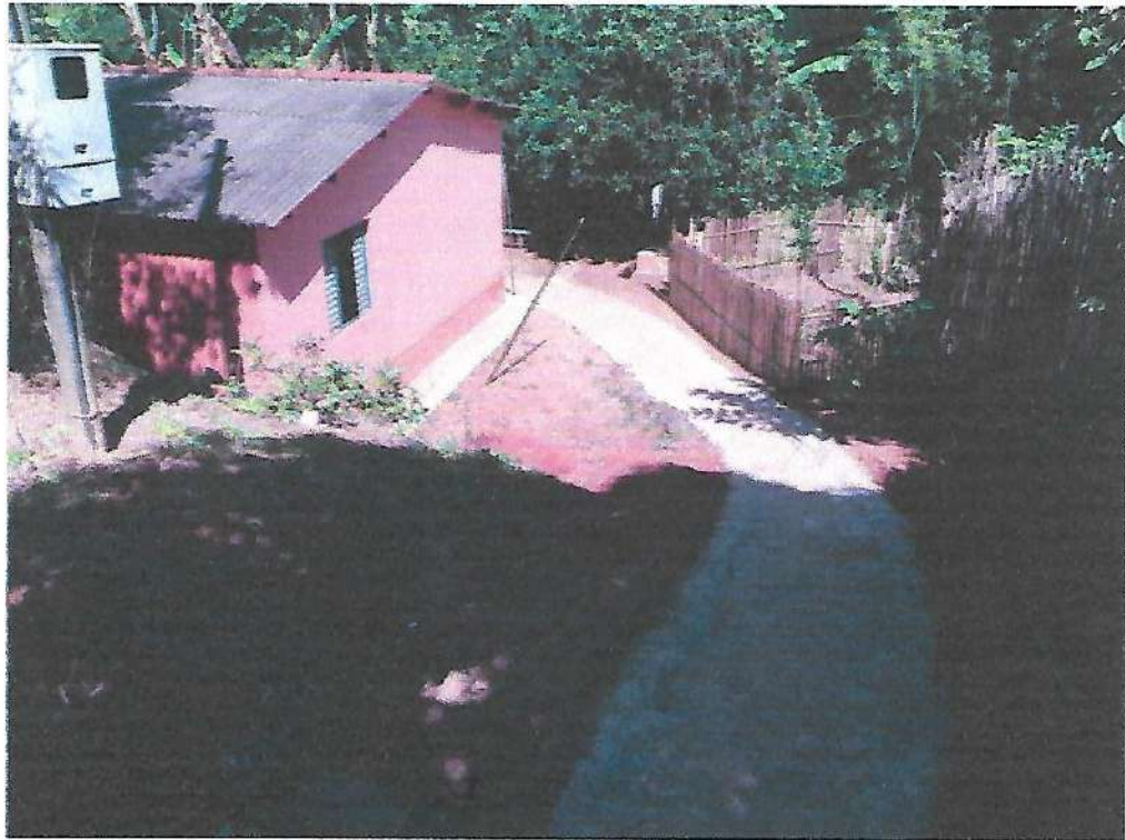
Imóvel localizado na Rua São Bartolomeu, S/N – Bairro do Rocio. Grau de Risco: Médio– com ressalva de monitoramento
