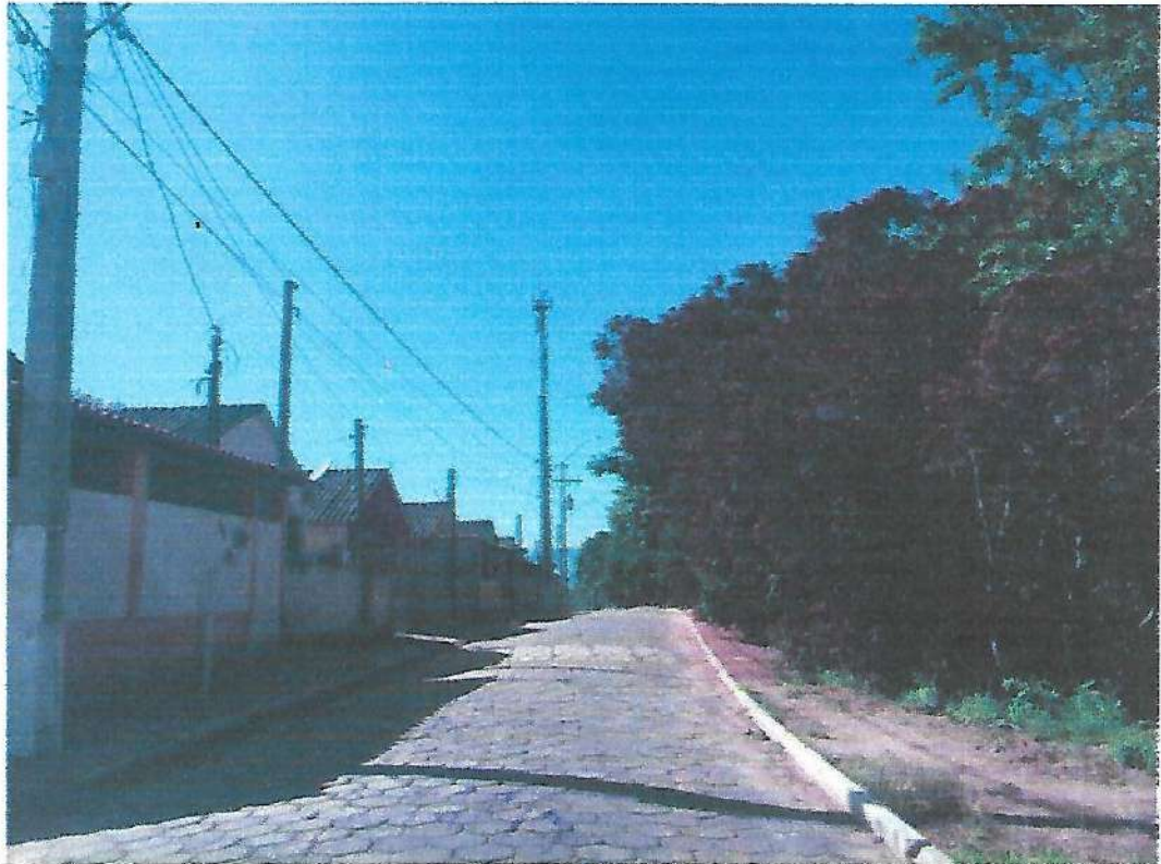
Imóvel localizado Rua São Bartolomeu, S/N – Bairro do Rocio. Grau de Risco: Leve – com ressalva de monitoramento
