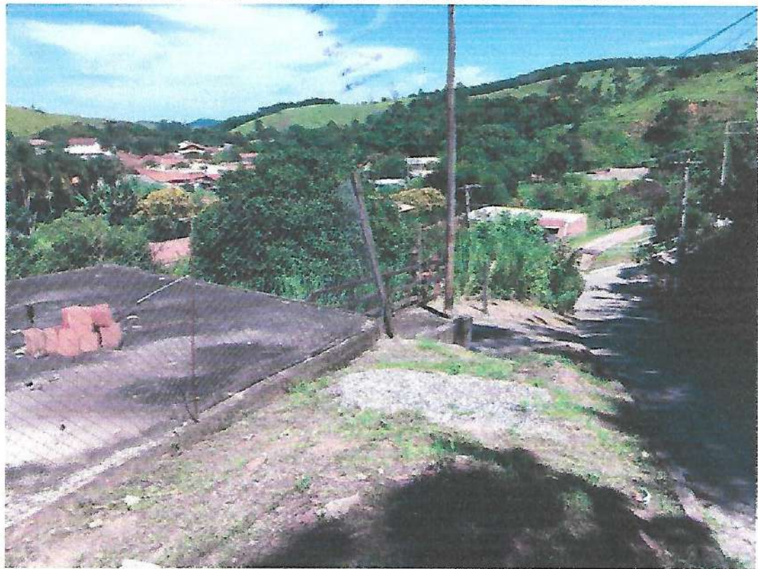
Imóvel localizado na Rua São João, S/N, Bairro do Rocio Grau de risco: leve, com recomendação de monitoramento.
