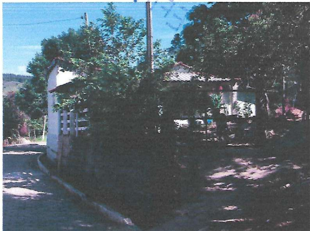
Imóvel localizado na Rua São Bartolomeu, S/N – Bairro do Rocio. Grau de Risco: leve – com ressalva de monitoramento
