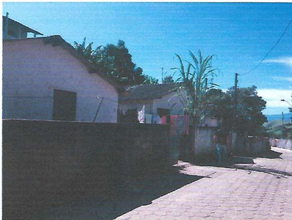
Imóvel localizado na Rua São Mateus, S/N – Bairro do Rocio. Grau de Risco: leve – com ressalva de monitoramento
