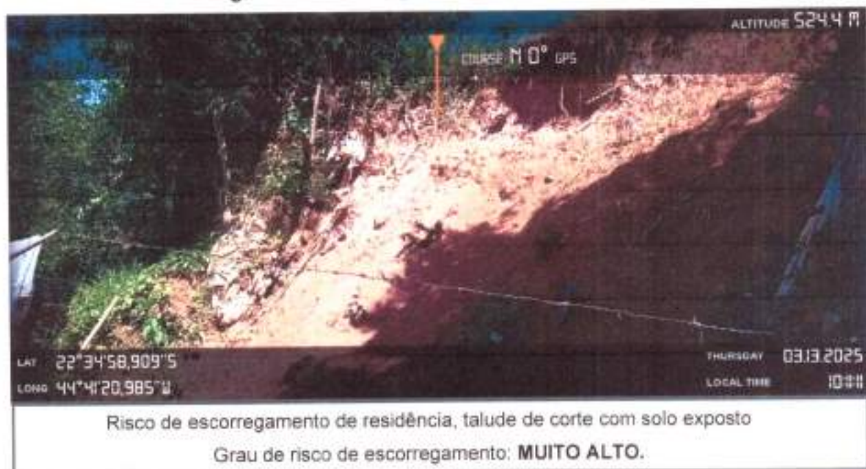
Imagem 18 e Área 8 (IMG-20250313-WA0016.jpg)
