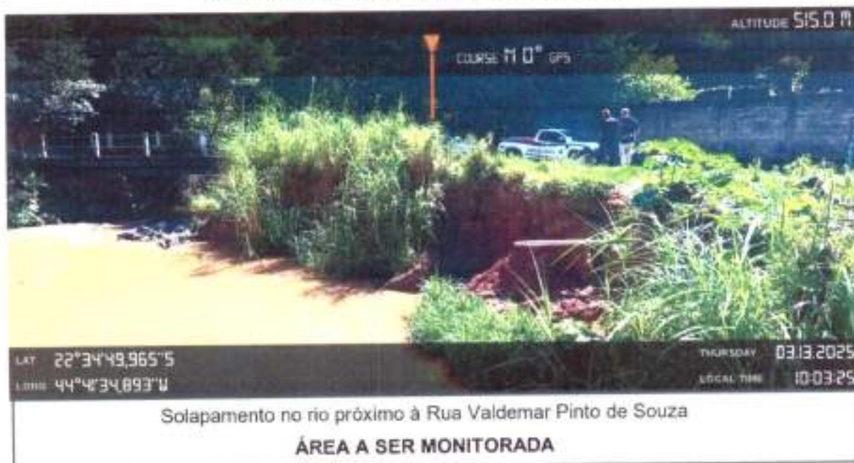
Imagem 15 e Área 6 (IMG-20250313-WA0021.jpg)
